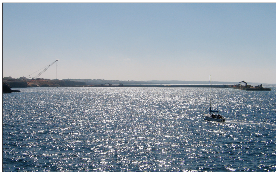
Avances les obres del dic segons el projecte que es va consensuar entre les diferents administracions implicades.
